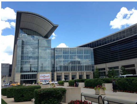
Konferenzzentrum McCormick Place (eigenes Foto)
