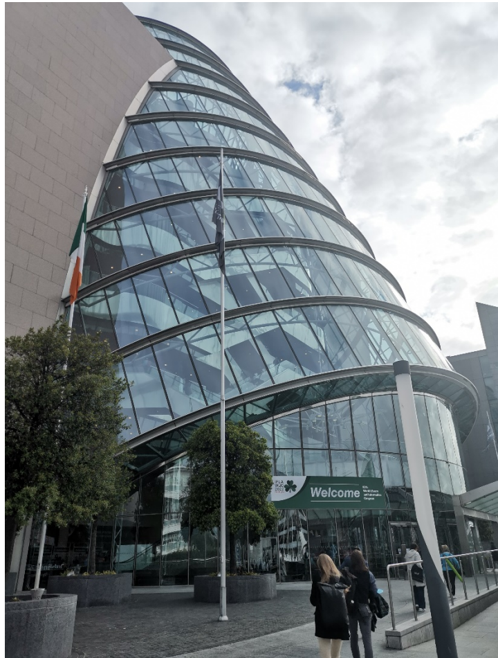
Abbildung 1 Außenansicht des Kongressgebäudes in Dublin Fotot: Yannick Pollmann ( CC BY-SA 4.0 )
